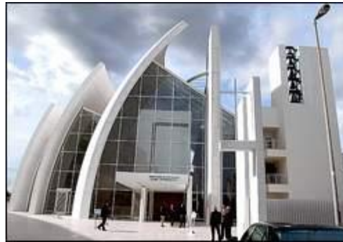
Budownictwo Samoczyszczący się beton
