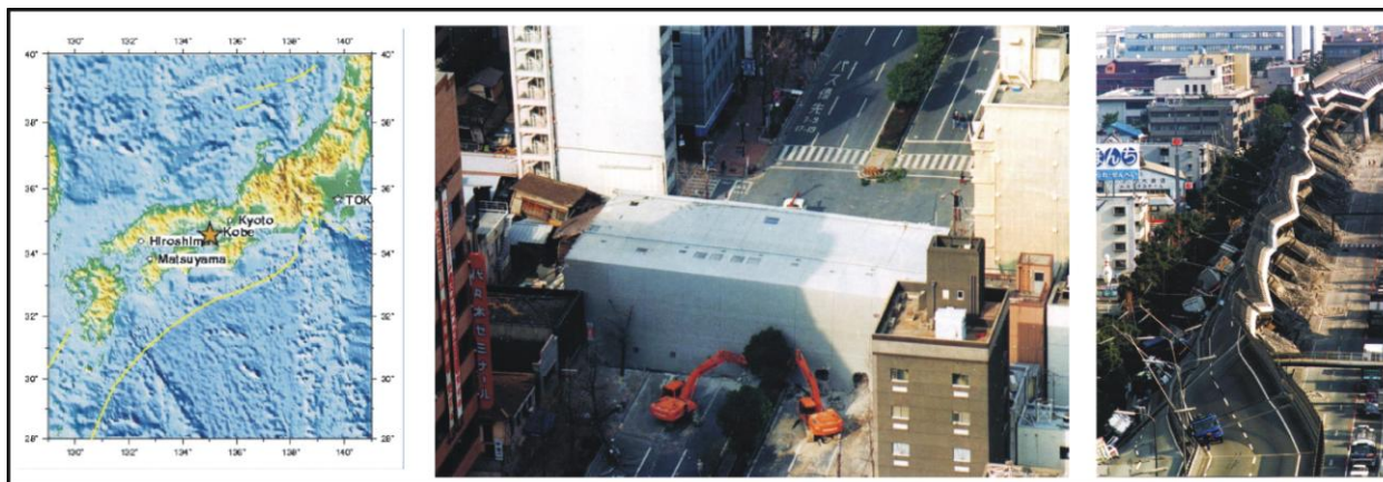
Rys. 3. Mapa z lokalizacją trzęsienia ziemi w Kobe oraz przykłady zniszczeń wywołanych trzęsieniem. Wielopiętrowy budynek został przewrócony na jezdnię – maszyny budowlane próbują dostać się do jego wnętrza w akcji ratunkowej. Podobnej wysokości sąsiednie budynki nie ucierpiały. Obok powalona estakada. Wielkość zniszczeń świadczy o wielkich przyspieszeniach ścinających podczas trzęsienia.
