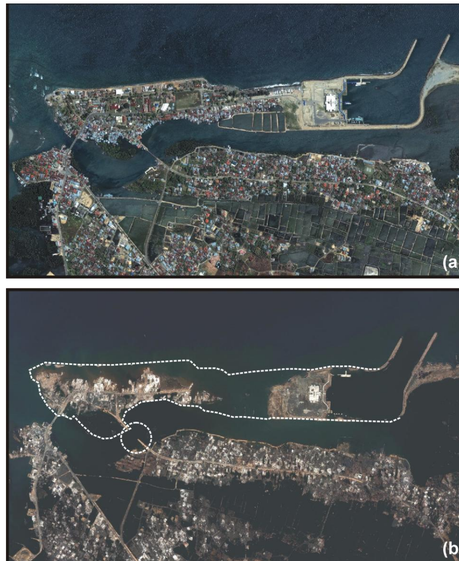
Rys. 22. Północne wybrzeże Sumatry, prowincja Banda Aceh; (a) przed (23 czerwca 2004) i (b) po tsunami (28 grudnia 2004). Biała przerywana linia pokazuje położenie linii brzegowej przed atakiem tsunami, a kółko zniszczony most ( http://www.globexplorer.com/disasterimages , © DigitalGlobe).
