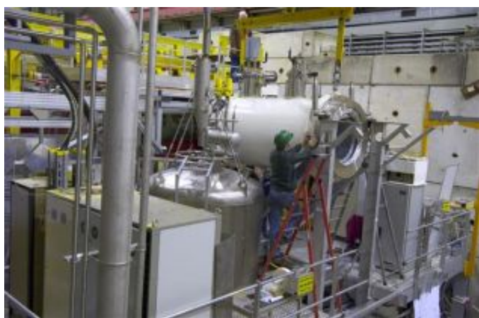
Eksperyment COMPASS - instalacja magnesu tarczy (źródło: CERN)
