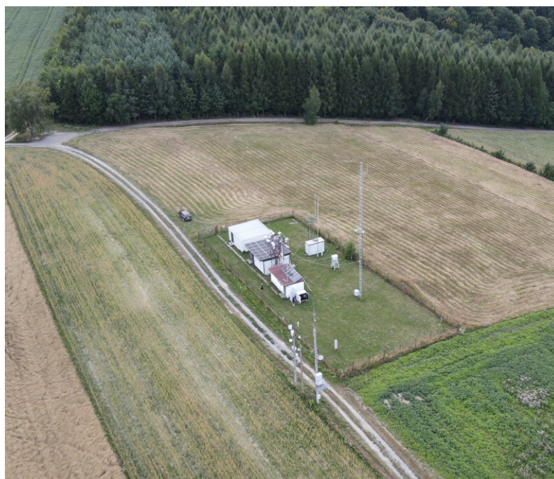
Rysunek 2.2: Zdjęcie wykonane za pomocą drona ukazujące stację SolarAOT oraz jej okolice.
