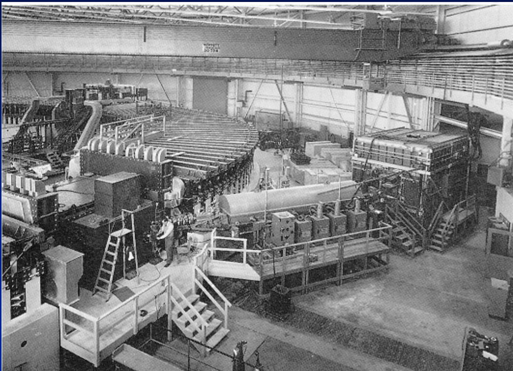
Akcelerator protonów w Berkeley zaprojektowano tak, aby przekroczyć energię progową dla produkcji antyprotonów w reakcji
