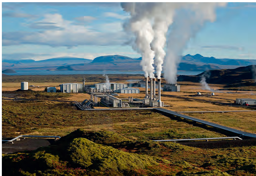
Fot. 16.3. Energia geotermiczna w Islandii. Średnia wytwarzana moc przez elektrownie geotermiczne w Islandii (której populacja wynosi 300 000) wynosiła w roku 2006 300 MW (24 kWh/d na osobę). Ponad połowa wytwarzanej tam elektryczności jest zużywana na produkcję aluminium. Fot. Gretar Ívarsson
