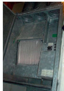
Fot. E.11. Wymiennik ciepła w Heatkeeperze.
