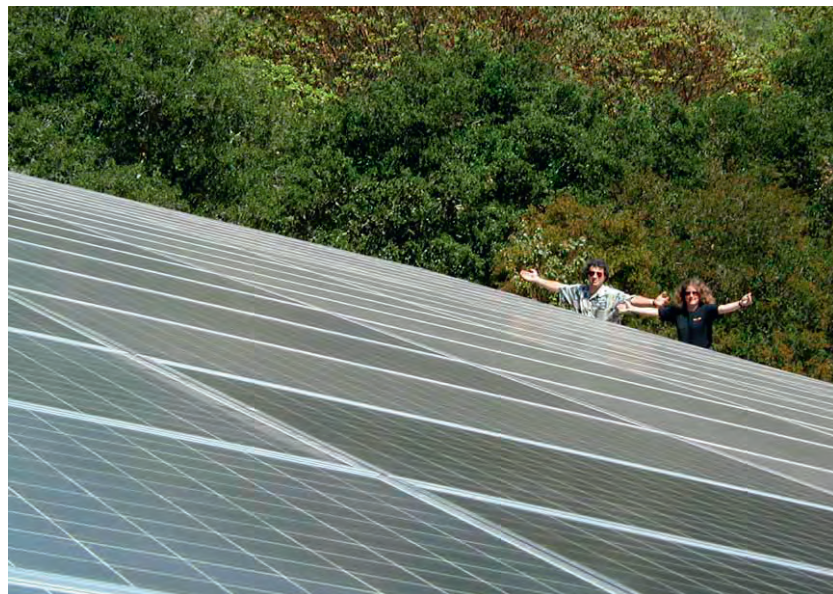
Fot. 6.6. Dwóch słonecznych wojowników cieszących się swoim systemem fotowoltaicznym, który zasila ich samochody elektryczne oraz dom. Układ 120 paneli (moc 300 W, każdy o rozmiarze, 2,2 m 2 ) ma powierzchnię 268 m 2 ; moc szczytowa (pokrywająca straty przy konwersji prądu stałego na zmienny) wynosi 30,5 kW, zaś średnia moc – w Kalifornii, niedaleko Santa Cruz – wynosi 5 kW (19 W/m 2 ).
