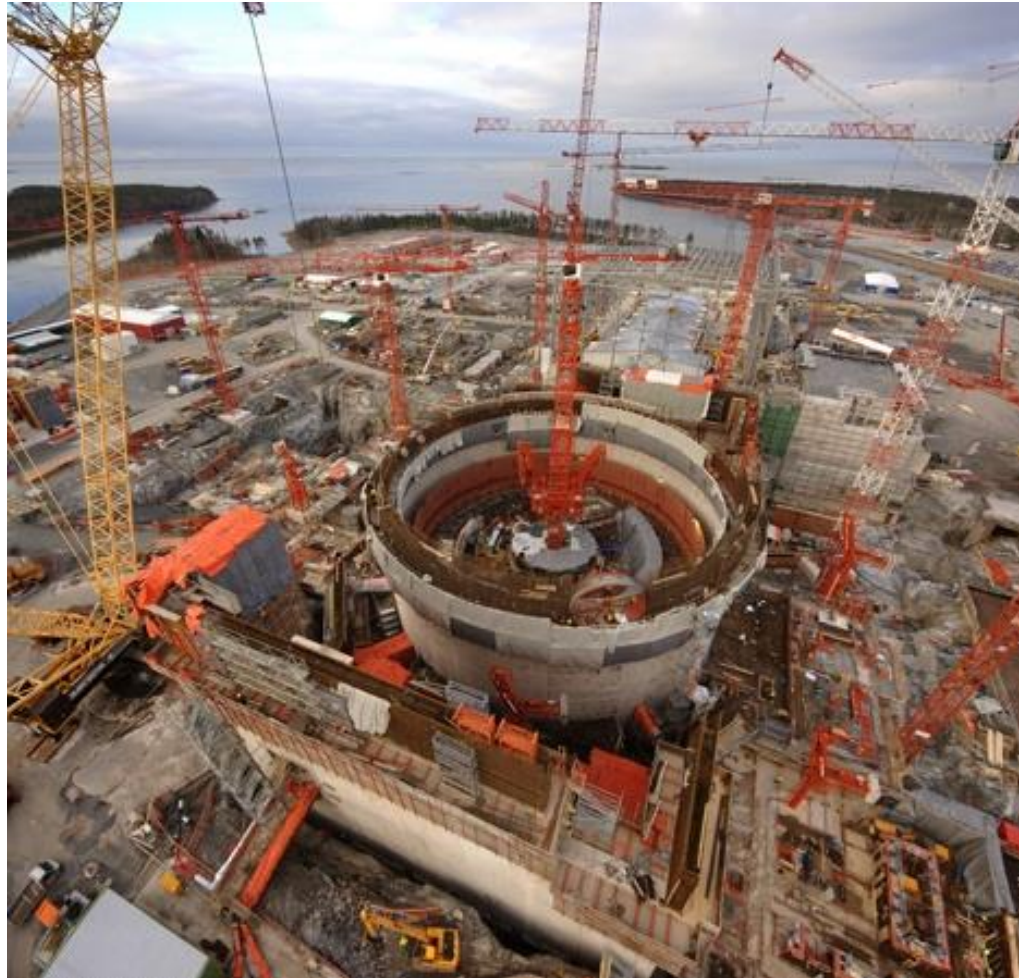
Budowa reaktora EPR w Olkiluoto (Finlandia). Styczeń 2008 roku. Copyright AREVA / P. Bourdon.
