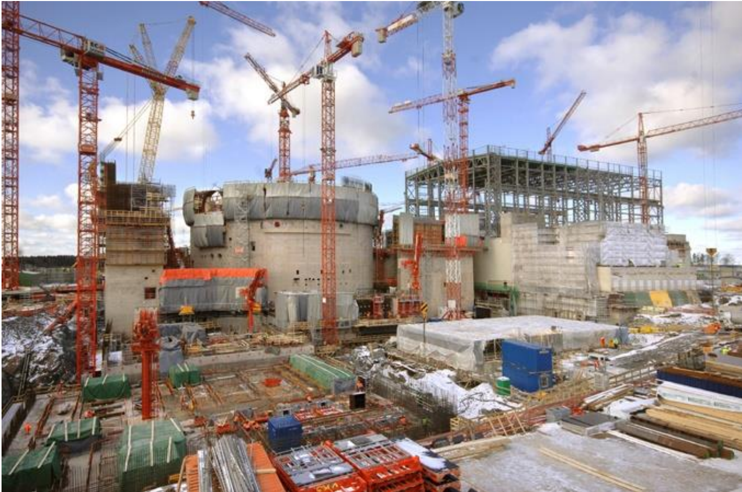
Budowa reaktora EPR w Olkiluoto (Finlandia). Marzec 2008 roku. Copyright AREVA / P. Bourdon.
