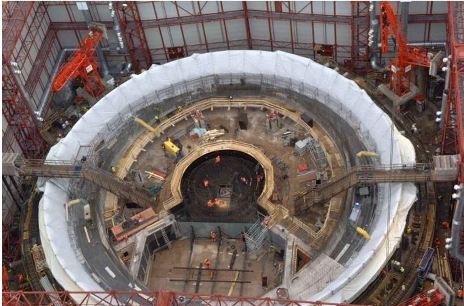
Budowa reaktora EPR w Olkiluoto (Finlandia). Marzec 2007 roku. Copyright AREVA / P. Bourdon.
