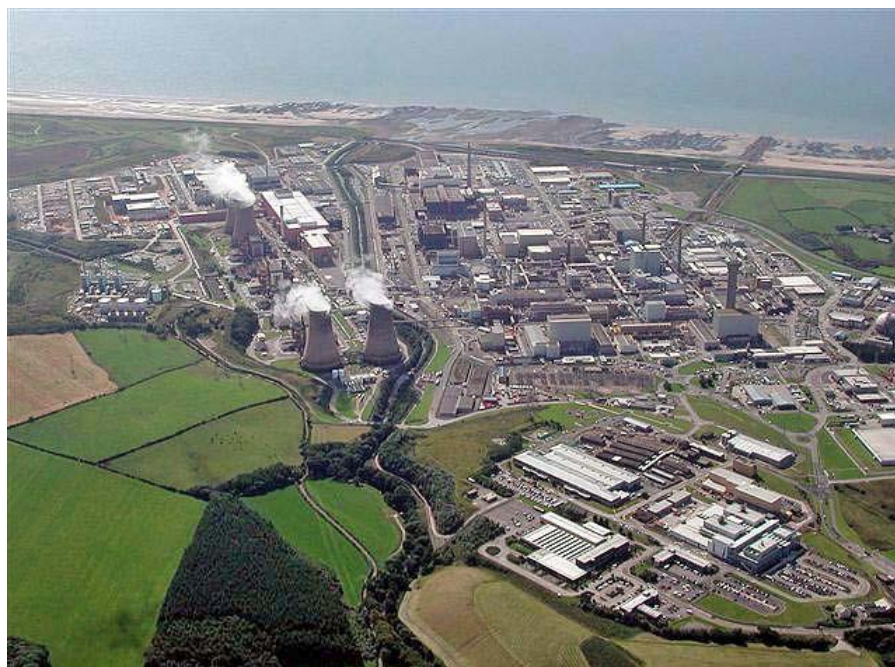
Rys. 1.12 Elektrownia jądrowa Calder Hall w ośrodku Sellafield w Anglii
